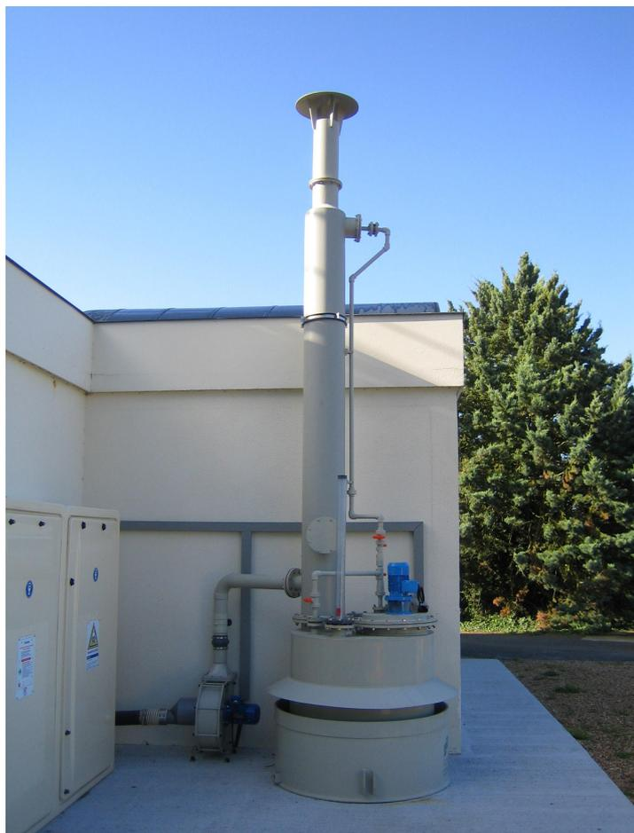
Le liquide de lavage (Na OH) est stocké dans le bac situé sous la colonne de lavage. Le bac de stockage est équipé d'une rétention.
